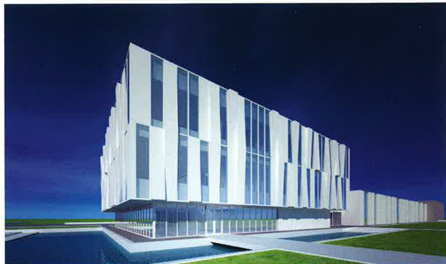
1. Stapeling van twee gebouwvolumes waarbij één bouwlaag is opgetild en naar voren verlegd.
