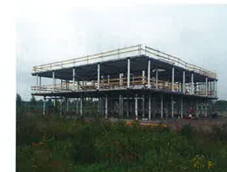
7. Verdiepingvloer 2 van kantoor is aangebracht.
